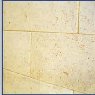
Fugenlos mörtelfrei gemauerter Brennraum schützt vor Rissbildung in den Feuerleichtsteinen Mortar free gaped firing chamber protects against splits in the fire bricks
