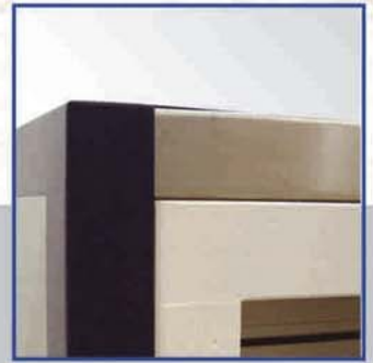
Edelstahlbleche an den Seiten, an der Tür und am Sturz Stainless steel sheets at the sides, the door and the upper frame
